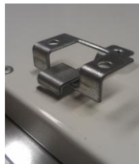
Detail eingehängte Deckenhalter
